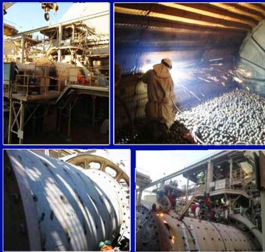
RECAMBIO DE REVESTIMIENTO DE MOLINOS
