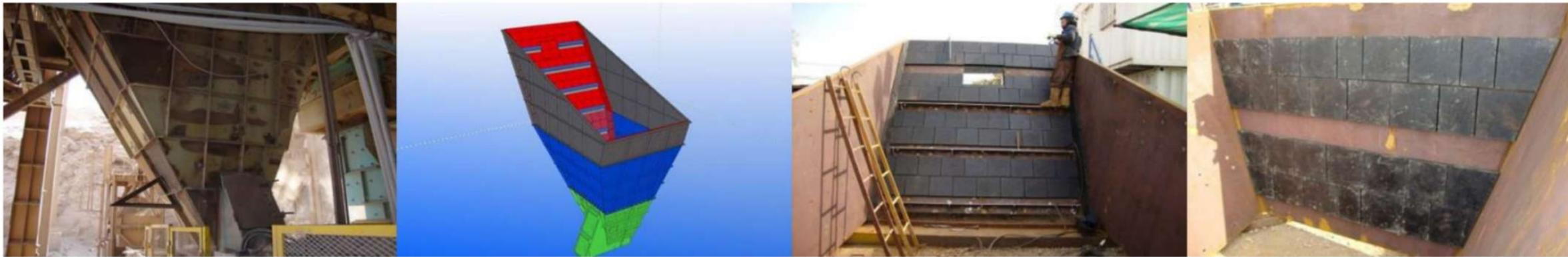
DISEÑO REPARACIÓN Y MONTAJE DE BUZON AREA CHANCADO FINO OXIDOS
