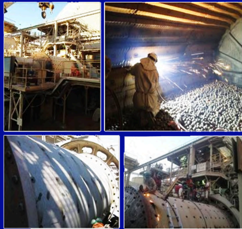
RECAMBIO DE REVESTIMIENTO DE MOLINOS
